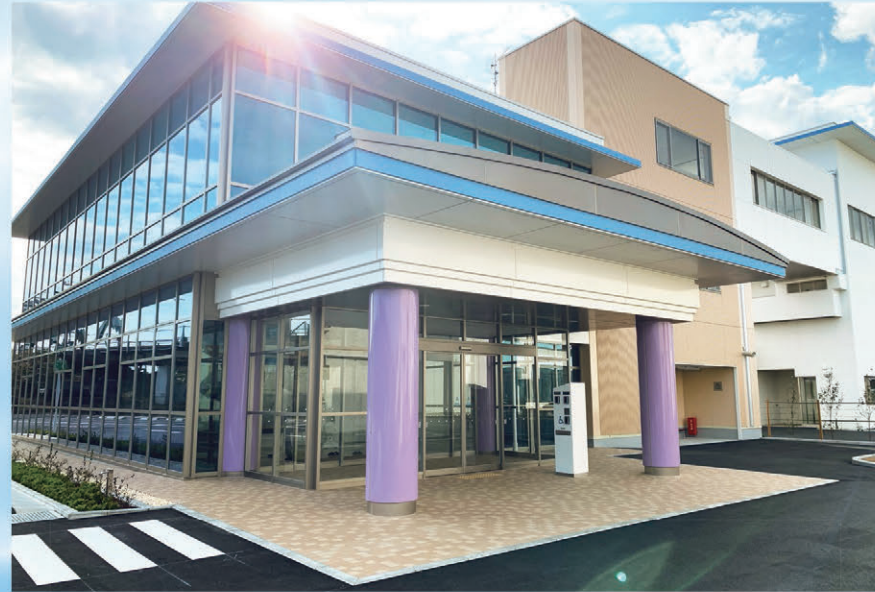
藤枝環境管理センター
